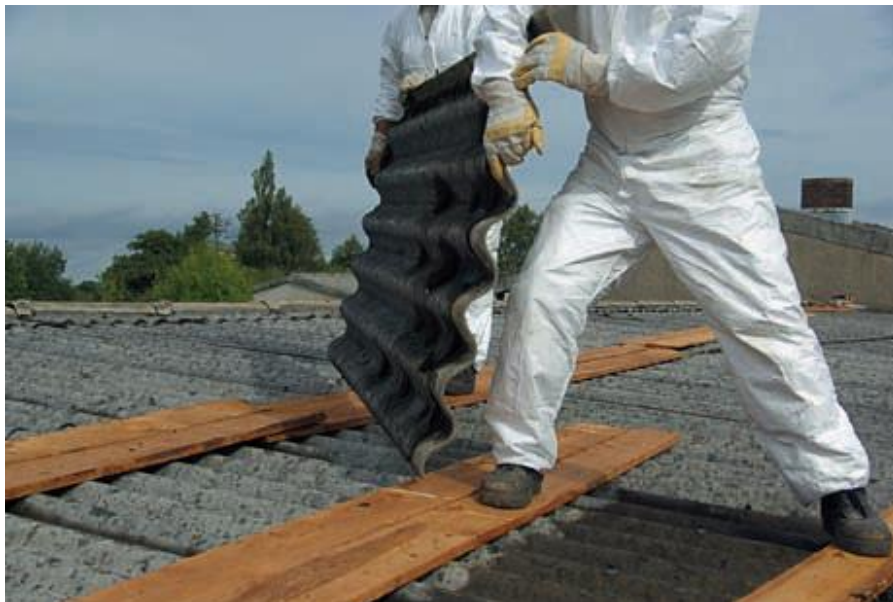
Rys.2 Demontaż płyt cementowo- azbestowych falistych 3 .
