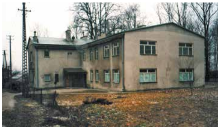
Dawny budynek przedszkola
