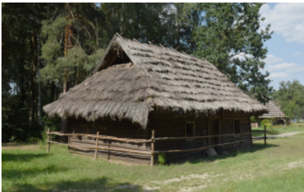
Dym w kurnych chatach unosił się na strych, a następnie poprzez dach słomiany na zewnątrz. MKL w Kolbuszowej
