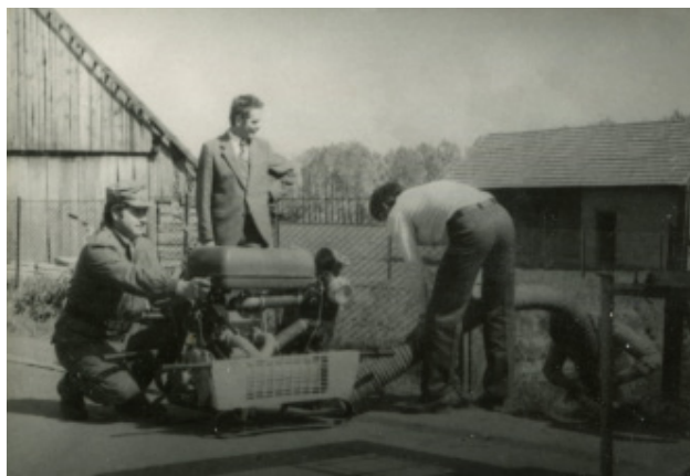
Pobieranie wody z basenu przeciwpożarowego przy użyciu motopompy M8/8 PO-5
