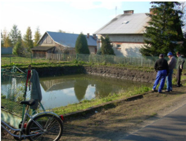
Demontaż ogrodzenia i przygotowanie zbiornika przeciwpożarowego do likwidacji jesienią 2008 roku. Ze zbiorów T. Mendrali
