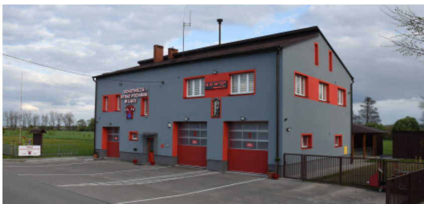
Dom Strażaka w Łące po odnowieniu elewacji. Fot. P. Smotryś
