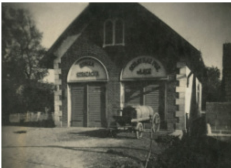
Budynek dawnej remizy OSP. Po prawej stronie znajdowała się posesja należąca do Tomasza Noworóla. Fotografia z I poł. XX w. Zbiory Z. Orzecha
