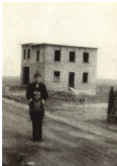
Budowa nowej remizy w latach 1965-69. Ze zbiorów Z. Orzecha
