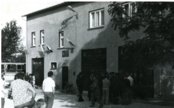
Rozbudowany i zmodernizowany Dom Strażaka w Łące w dniu uroczystego otwarcia. Widok od strony północnej, KOSPŁ
