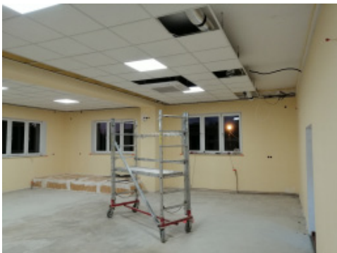
Prace remontowe wewnątrz Domu Strażaka
